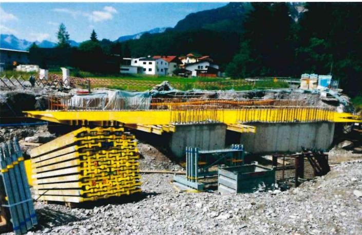
Eine zweite Brücke, direkt am „Durchlass Umfahrungsstraße“, dient nicht nur der Verkehrsbindung, sondern auch als Drosselbauwerk für einen hochwasserführenden Lußbach. Dieses Brückenbauwerk und die in den letzten Jahren erfolgte Aufweitung des Bachbettes sorgen dafür, dass in Zukunft mit keinen Überschwemmungen mehr zu rechnen ist und das gesamte Baugebiet hochwassersicher ist.
