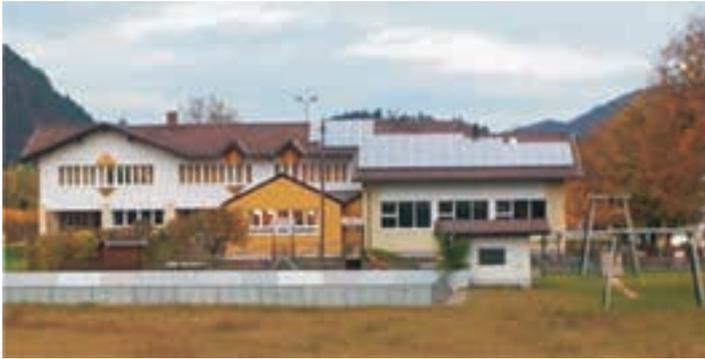
Drei Monate dauerten die Sanierungsarbeiten an unserer Volksschule. Sämtliche Fenster und die Außentüren wurden getauscht. Gleichzeitig wurden die Außenwände isoliert. Nicht nur der Energieverbrauch wird dadurch wesentlich gesenkt, auch optisch erstrahlt das Gebäude in neuem Glanz. Im kommenden Frühjahr werden an den südseitigen Fenstern noch sogenannte „Markisioletten“ angebracht, die dem Sonnenschutz dienen.
