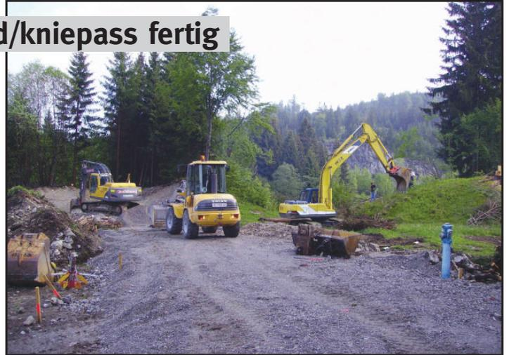
Schwere Baumaschinen waren beim Bau der Erschließungsstraße mit Kanal- und Wasserleitung notwendig. Inzwischen ist das Teilstück fertig gebaut und die erste Bauverhandlung (Fa. Phystech) konnte durchgeführt werden.
